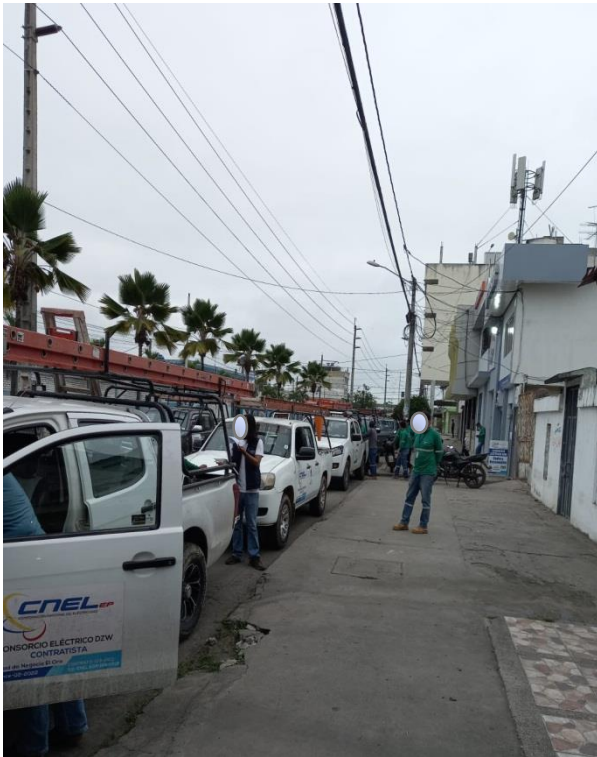
Figura 1 Puesto trabajo del administrador Fuente. Liz Peña, 2023.
