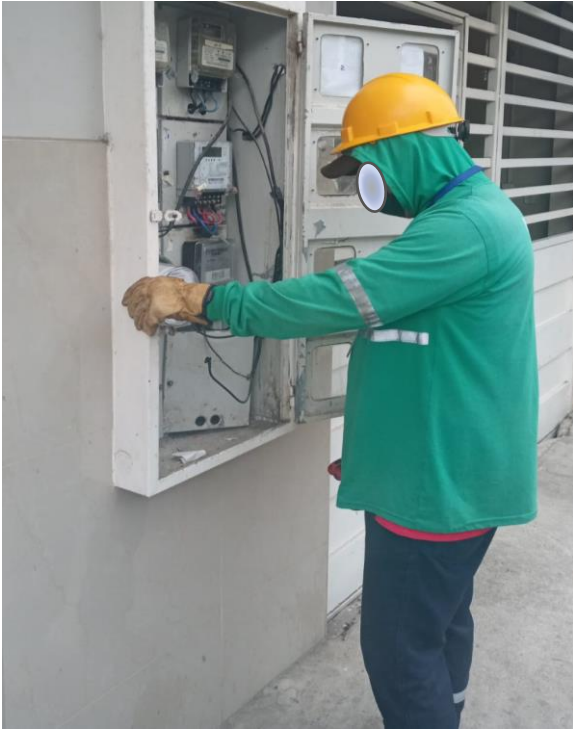
Figura 5 Puesto trabajo de electricistas realizando corte en un panel Fuente. Liz Peña, 2023.
