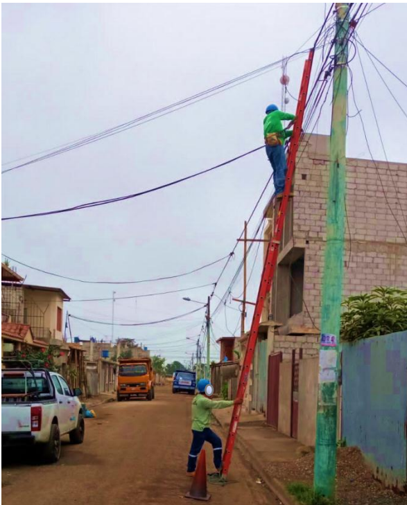
Figura 6 Puesto trabajo de electricistas realizando reconexión al poste Fuente. Liz Peña, 2023.
