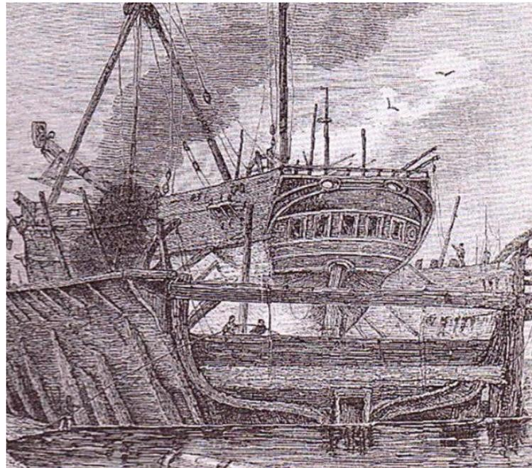
*Figura 2 Dique flotante en Rotherhithe (1820)*
