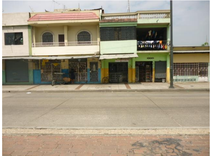
Viviendas y tiendas frente al proyecto
