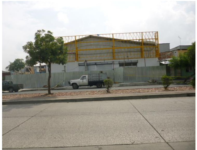
Lugar donde se construye el proyecto del Mi Comisariato MINI Local 15
