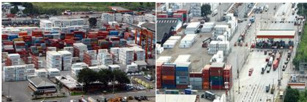
Figura 23.- Vista Panorámica de la Terminal
