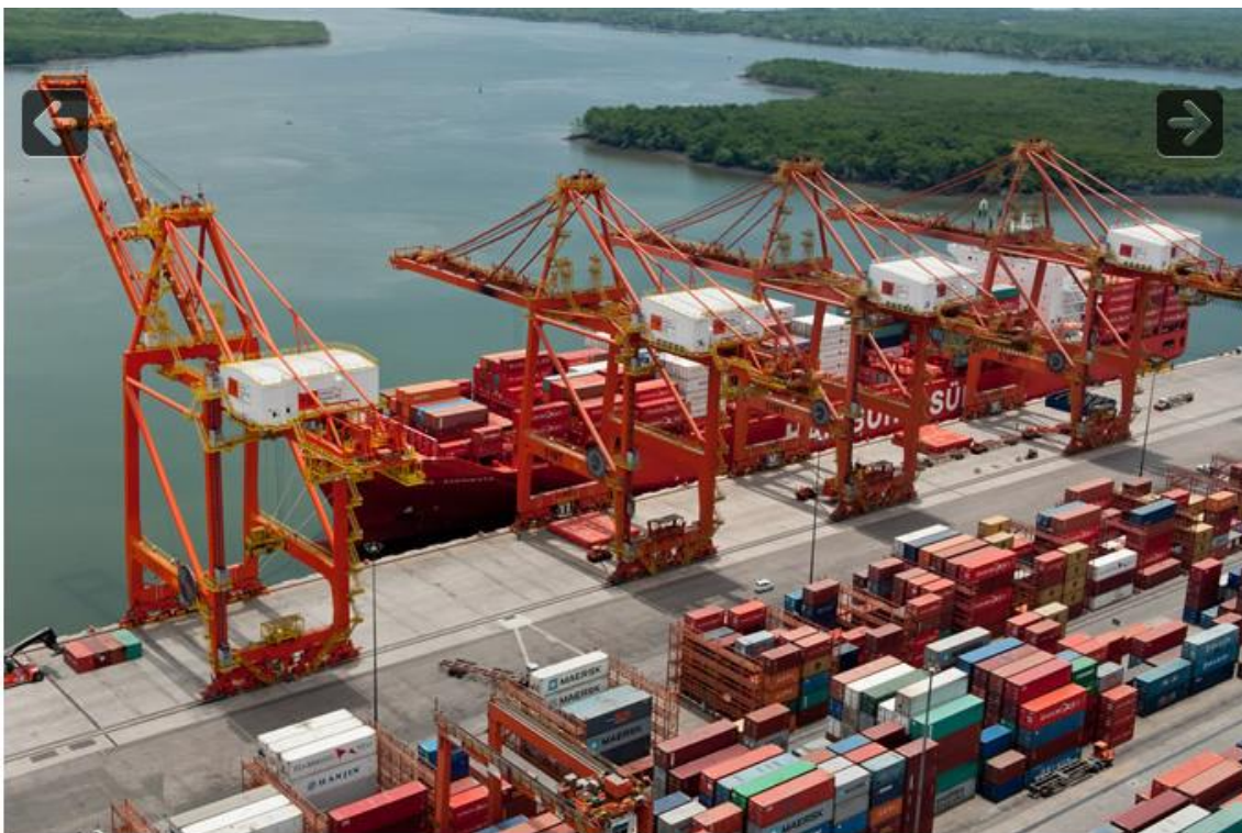
Figura 6.- Muelles para Buques Portacontenedores
