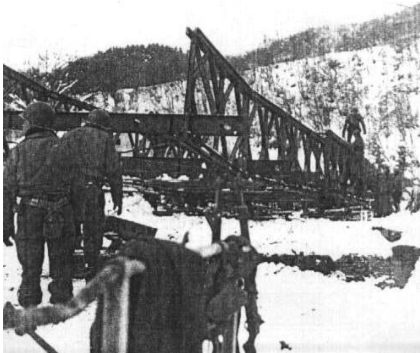
Lanzamiento de un puente Bailey durante el invierno de 1944 – 1945
