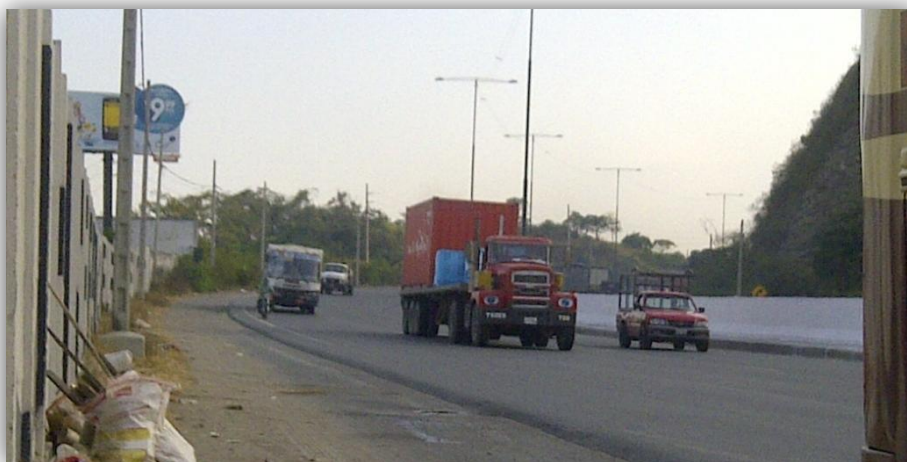
Fotografía No. 3.10 Vía Perimetral, Guayaquil. Fuente: Julio C. Tapia, 2013.
