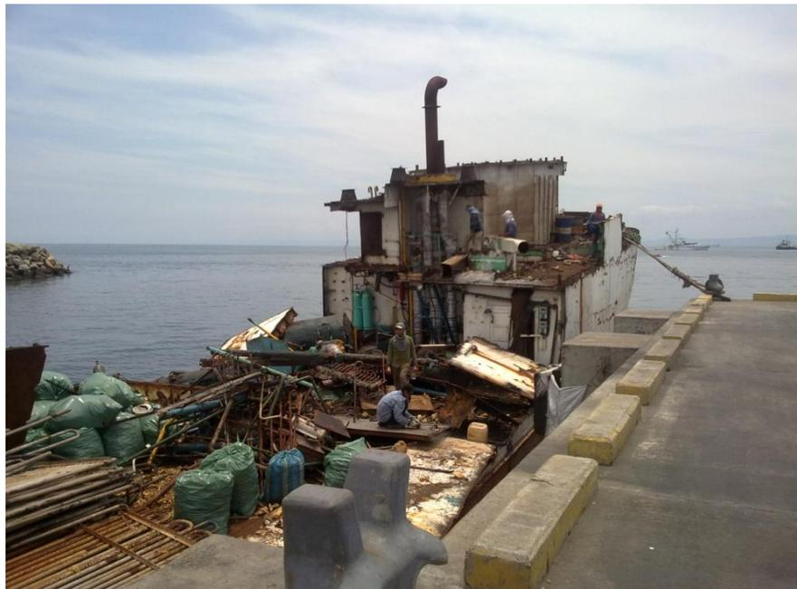
**Ilustración 12 Buque Jet Mark en proceso de desguace.**
