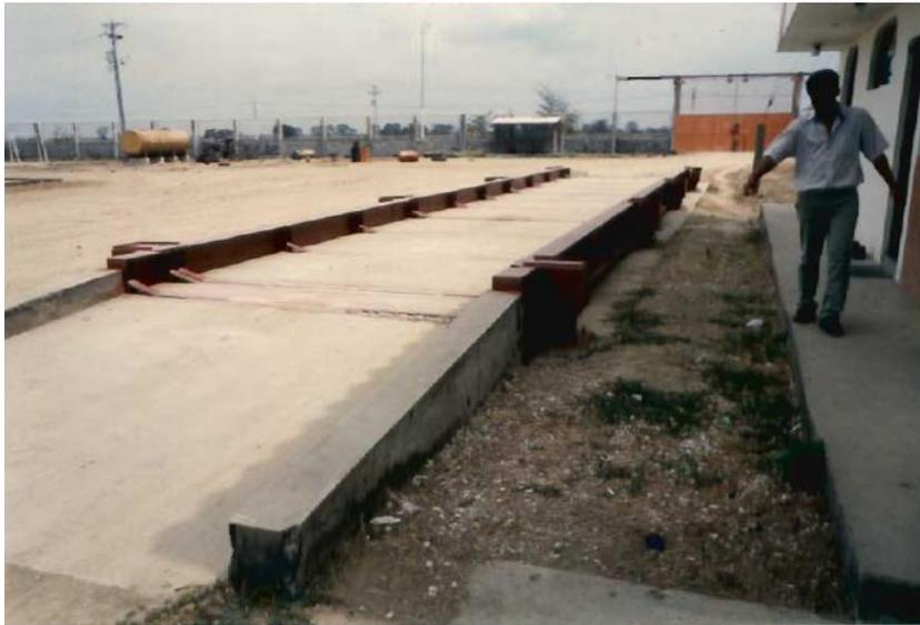
BASCULA CON LOSA DE CONCRETETO Y RAMPA DE CONCRETO
