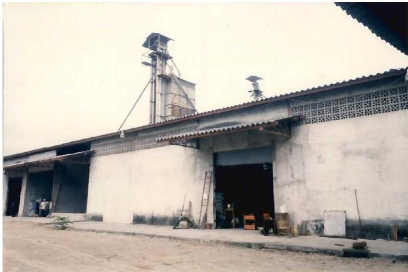
ESTRUCTURA METÁLICA CON PAREDES DE BLOQUE DE HORMIGÓN Y TECHO DE ETERNIT
