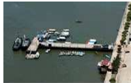
Fig. 4._ Espigón de Cabotaje
