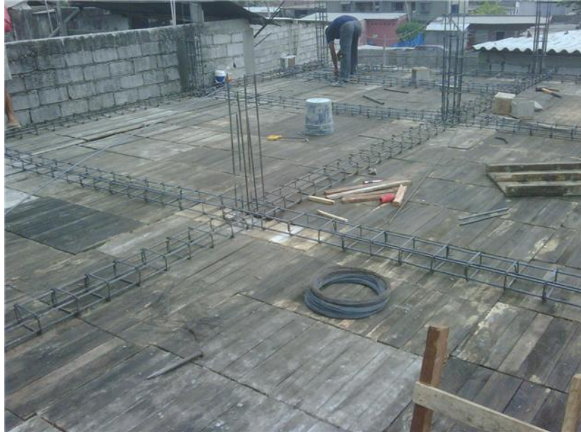
Grafico # 36 Encofrados Fuente: Obra. Vergeles
