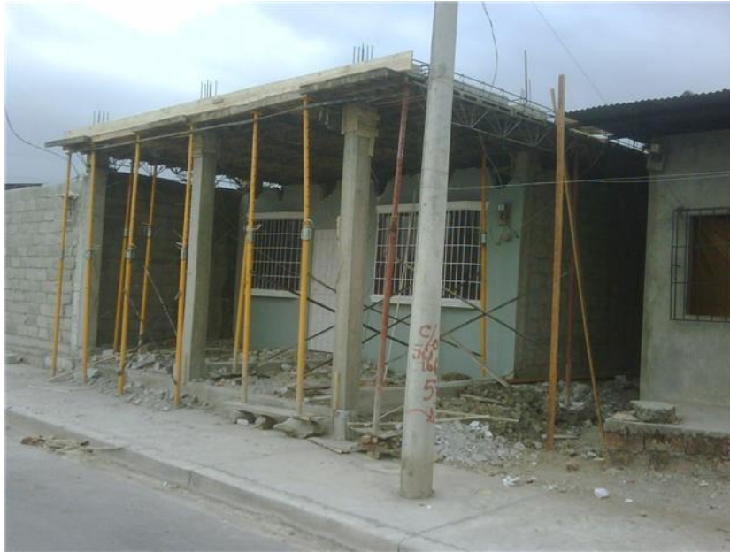
Grafico # 34 Encofrados Fuente: Obra. Vergeles
