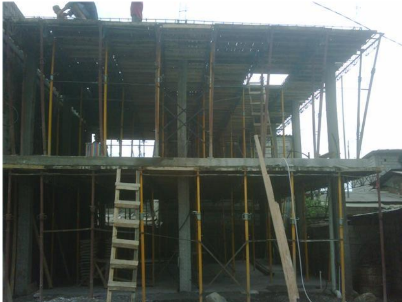
Grafico # 35 Encofrados Fuente: Obra. Vergeles
