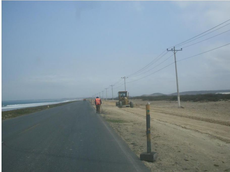
Carretera de la Ruta Del Sol.
