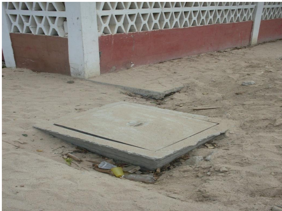
Sistema de Alcantarillado Sanitario (Fase de instalación de red de tuberías).
