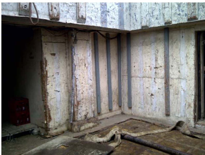
Fig. 10 Mal estado de Bodegas de los buques que llevan carga hacia Galápagos
