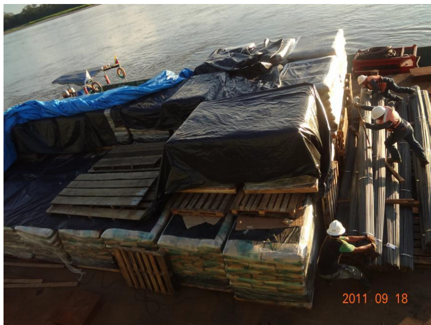
Puerto Itaya: Barcaza cargada (cemento)
