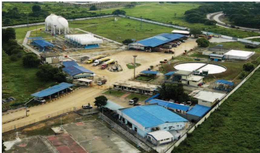
Terminal de GLP “El Salitral”
