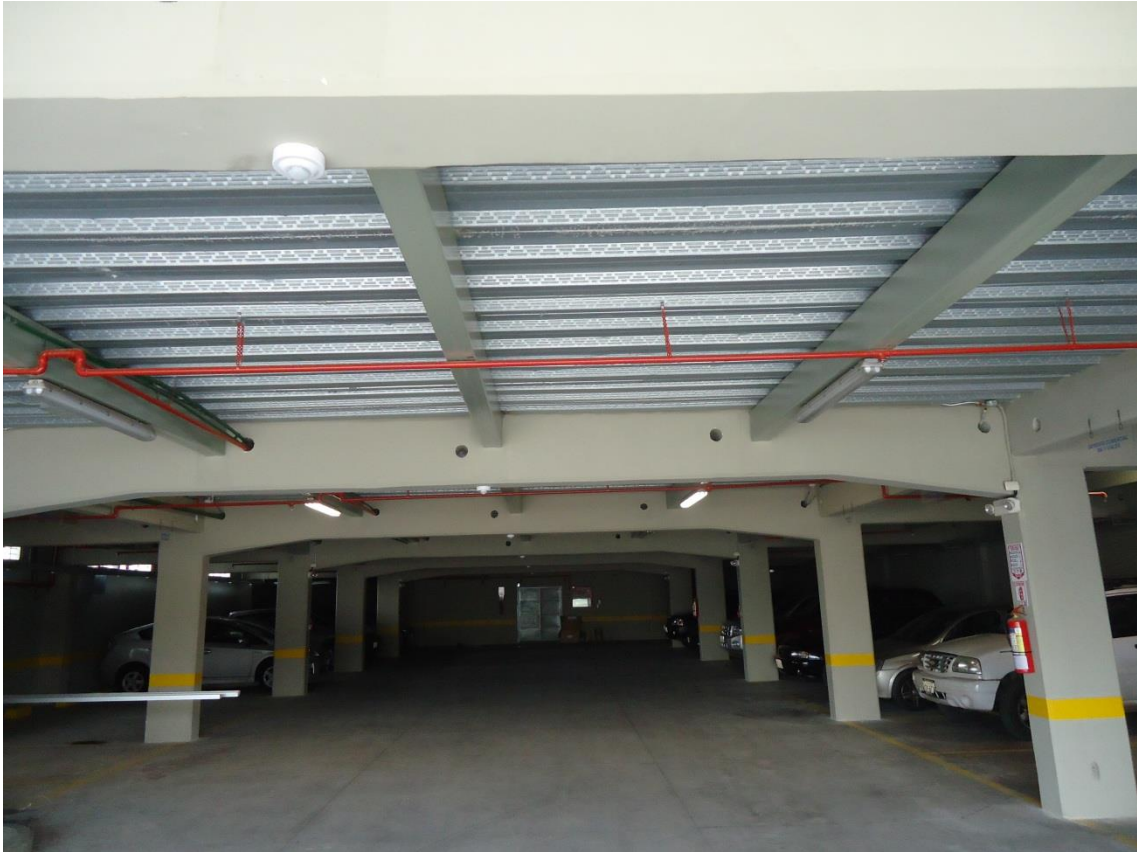
Foto No. 4: Instalación terminada de placa colaborante y vigas metálicas.
