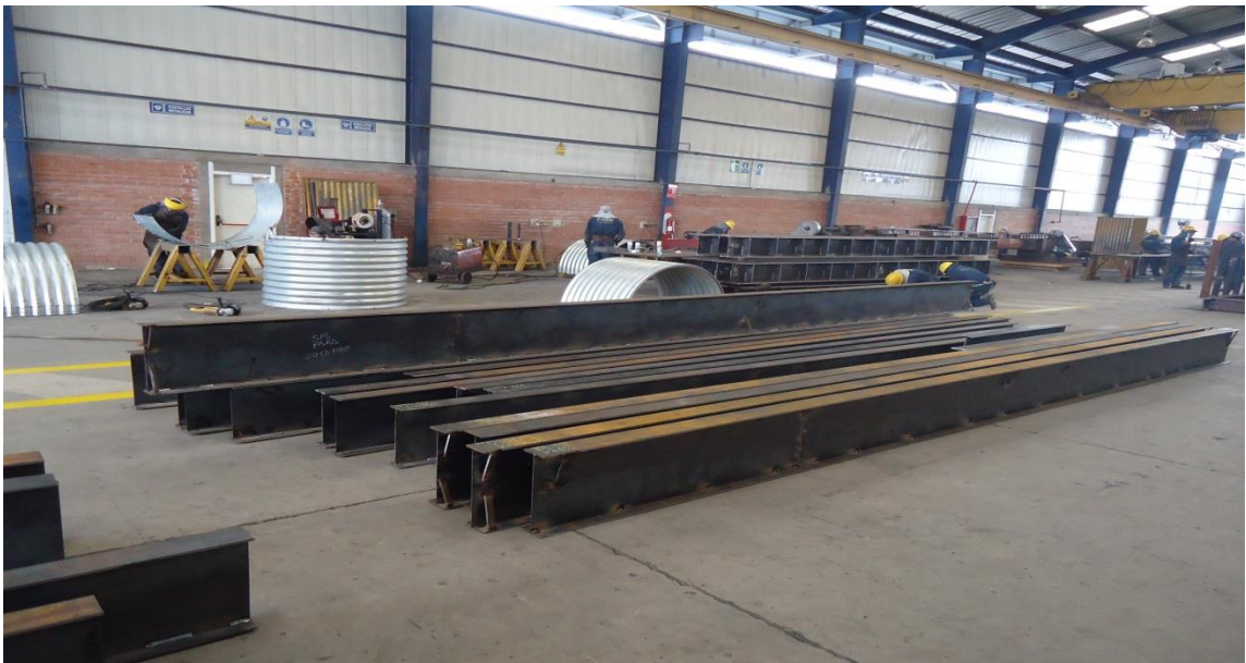
Foto No. 2 : Vigas procesadas listas para aplicación de pintura
