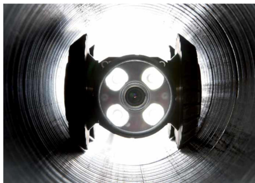
Figura 18 Vista de sistema de inspección
