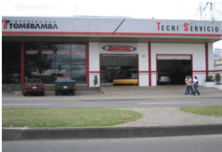
Fotografía 2.5.- Fachada Tecnicentro Importadora Tomebamba, Av. España
