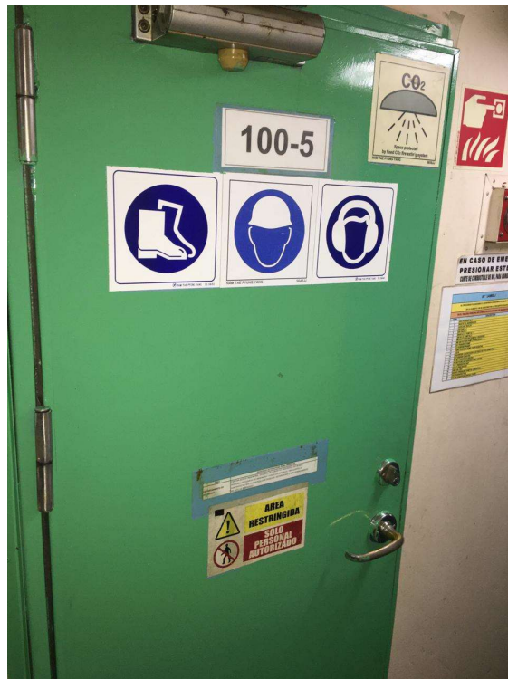
Ilustración36: Entrada de la sala de máquinas con la señalética correspondiente
