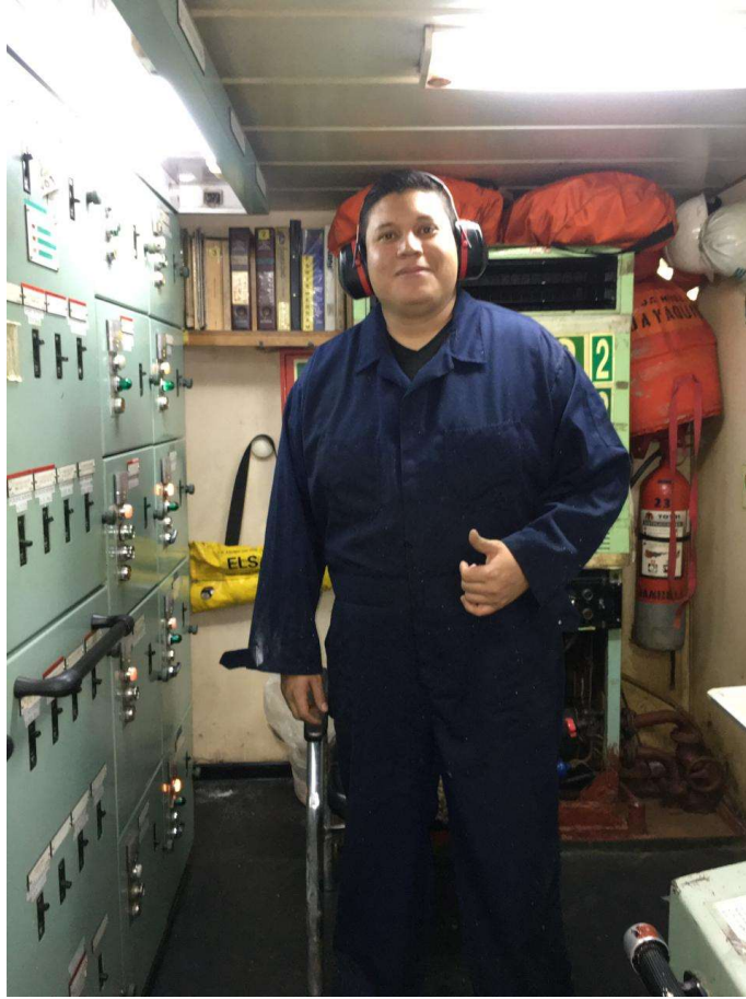
Ilustración24: Personal laborando en la sala de máquinas del BT Jambelí
