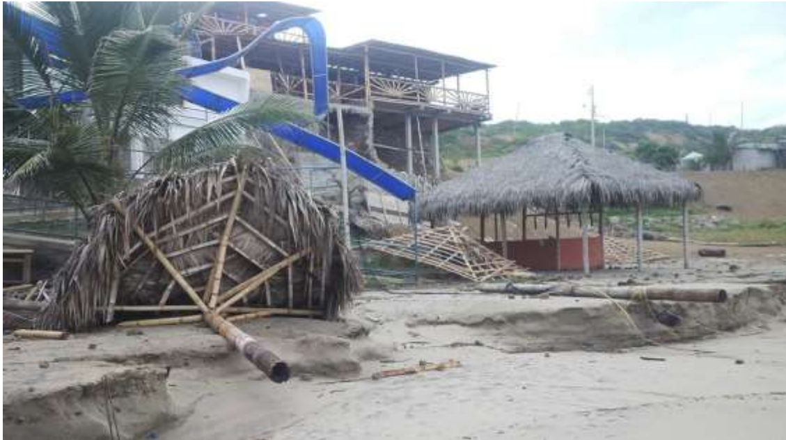
Figura 36 Destrucción de bohíos a lo largo de la playa de Libertador Bolívar. Fundación Coastman Ecuador, año 2015
