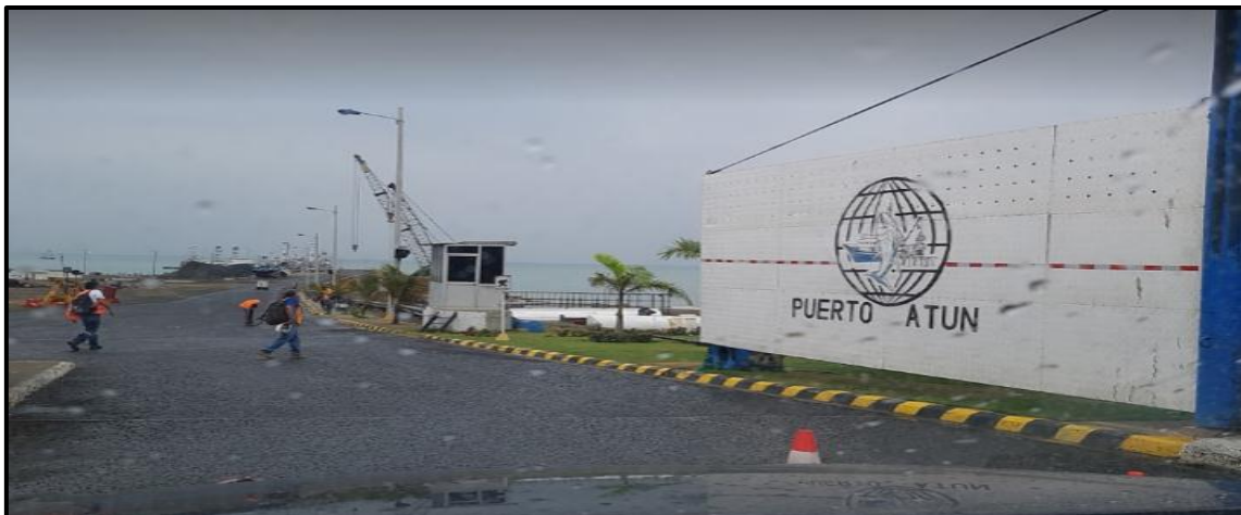
Figura 3. Estructura física del muelle de Puerto Atún Fuente: PDOT (2014)
