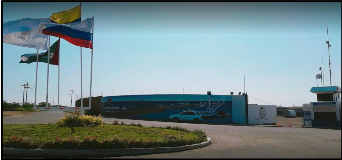
Figura 2. Estructura física del muelle de Puerto Atún Fuente: PDOT (2014)
