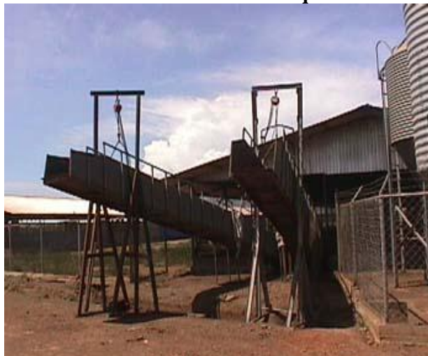
Figura No.7.96. Embarcaderos metálicos que se usara en Procera
