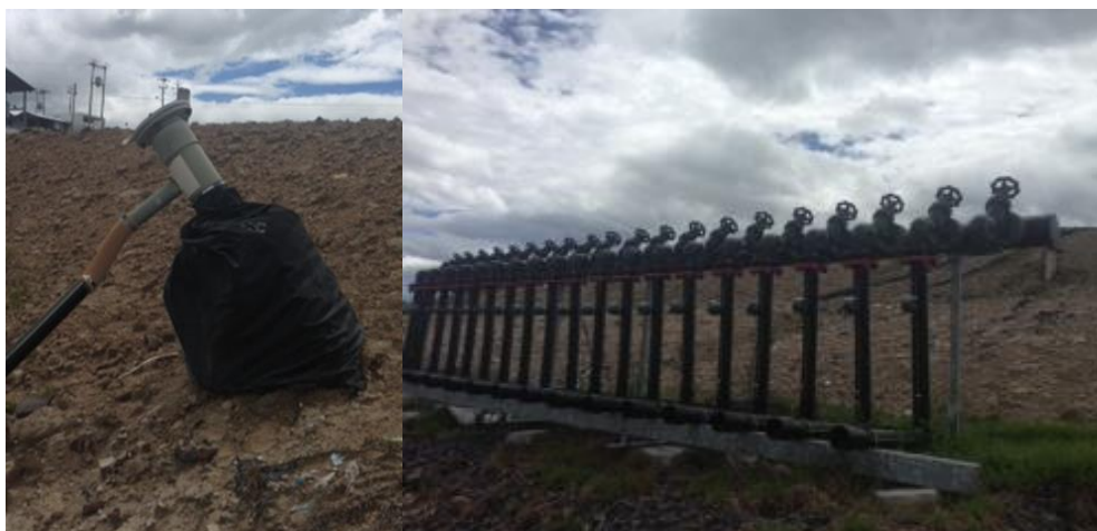
Figura No. 25 Sistema de mangueras para captación de biogás en el Relleno Sanitario El Inga
