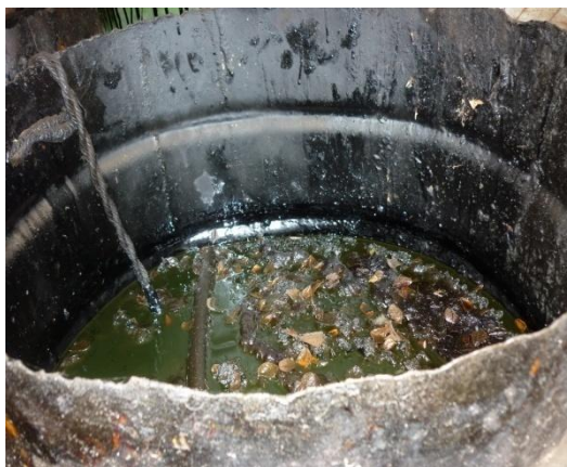
PISCINA DE LODOS N° 7
